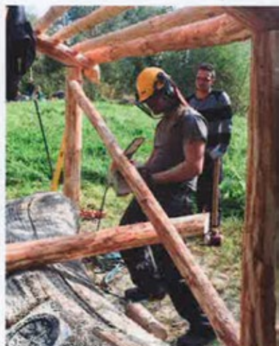
Das Dach nimmt Form an
